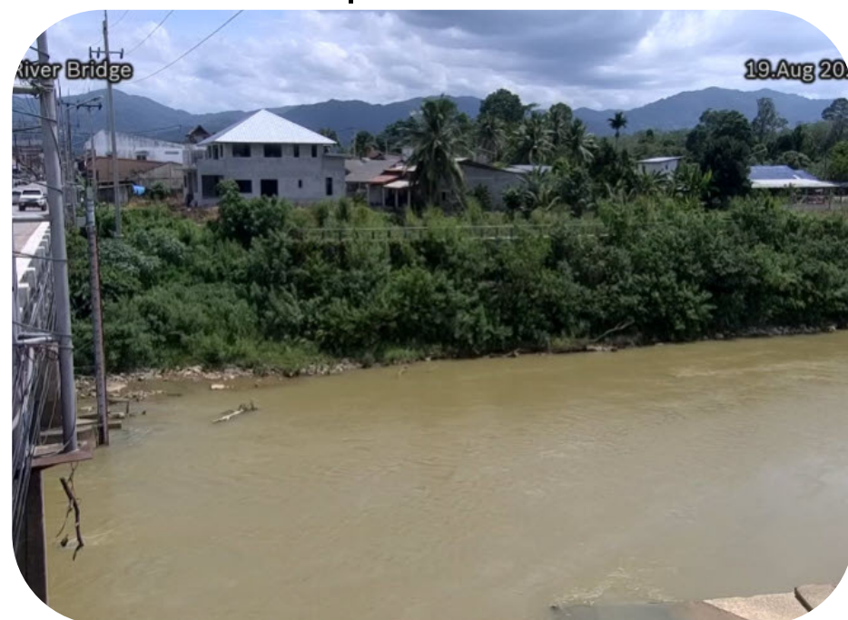
สะพานแม่น้ำสายบุรี อ.ศรีสาคร จ.นราธิวาส
